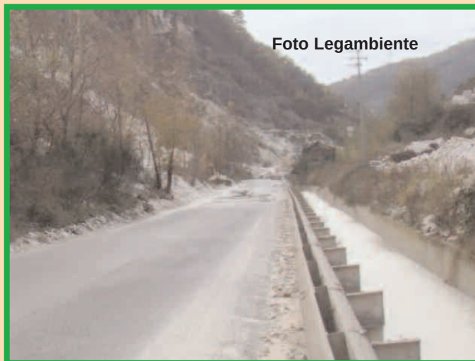
Fig. 1: Canale di Sponda, oggi. L'alveo ristretto è confinato in un canale in cemento per "guadagnare" spazio per la strada per Ravaccione.
